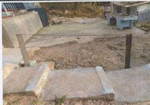
Foto 16: Refuerzo de baranda de metal lado derecho de la rampa medida de 1*14mts
