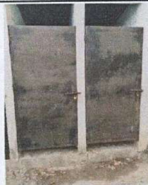
Foto 14: Reparación de 2 puertas de metal lijado, pintura. Y pasador medida de 1 * 2 mts
