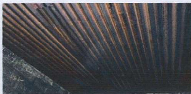
Foto 6: Sustrucion de lámina en mal estado por lamina troquelada calibre 26
