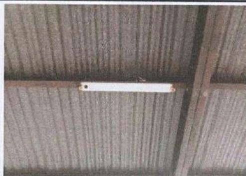
Foto 10: Sustrucción de sistema eléctrico incluye unidades de fuerza e iluminación (13 plafoneras, 13 focos, 1 apagador, dos tomacorrientes y cableado)
