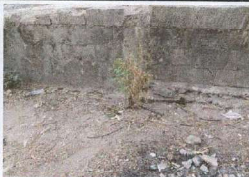
Foto 9 : Reparación y refuerzo en muro de block con cemento
