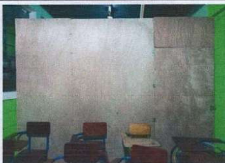
Foto 3: Reparacion y refuerzo a muro de tabla yeso de bodega 4mts de ancho * 5 de largo
