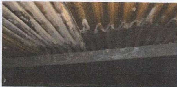
Foto 7: Sustrucción de estructura de techo por estructura de metal galvanizado.
