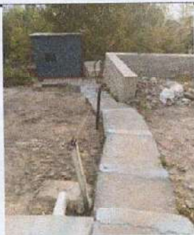
Foto 15 :Tallado de las gradas de ingreso ya que no todas tienen la misma medida
