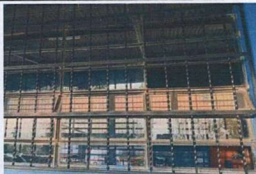
Foto2: Sustrucion de un balcón de metal con medida de 2,89 * 1,83 mts
