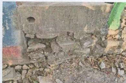
Foto 8: Reparación y refuerzo de banqueta de block y concreto
