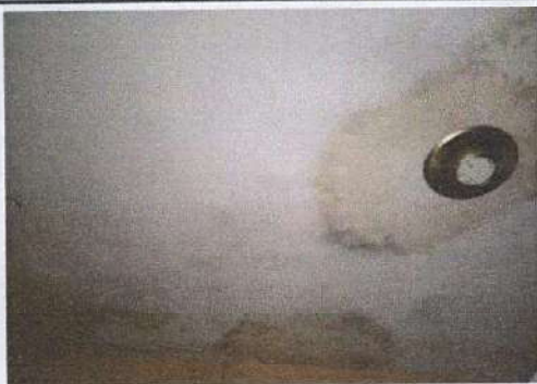
Foto 13: Reparación de losa de sanitarios incluye escarillado, limpieza, reparación de acabado rustico
